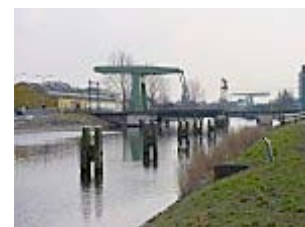
Spoorbrug Alkmaar, Alkmaar
