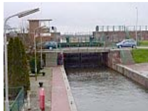
Brug Overlekersluis, Medemblik
