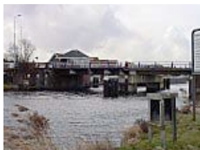
Brug Oude Wetering, Haarlemmermeer
