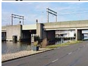
Spoorbrug Kaag, Haarlemmermeer
