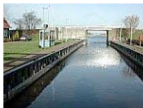
Brug Braaksluis, Niedorp
