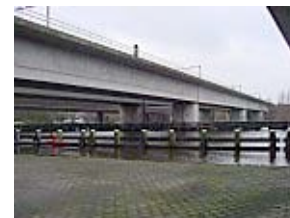
Spoorbrug A10, Amsterdam
