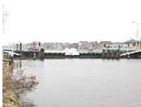
Vlotbrug 't Zand, 't Zand
