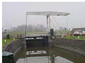
Brug Kloosterdijksluis, Waterland
