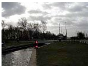
Zanderijbrug (N523), Weesp
